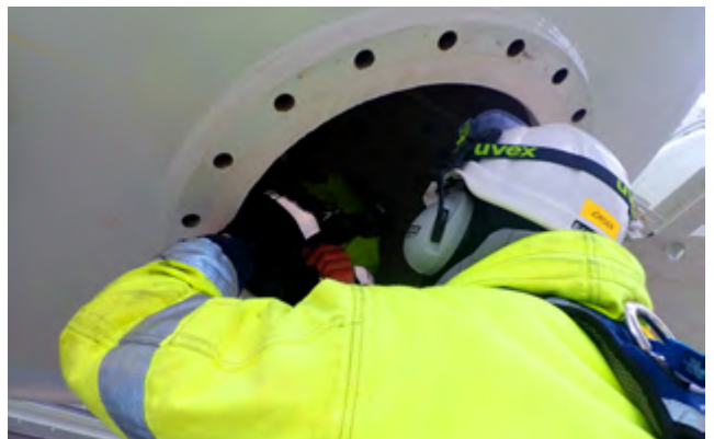
Inspektion av ett nytt kolfilter till den nya klorprocessen som ska rena saltlösningen.
