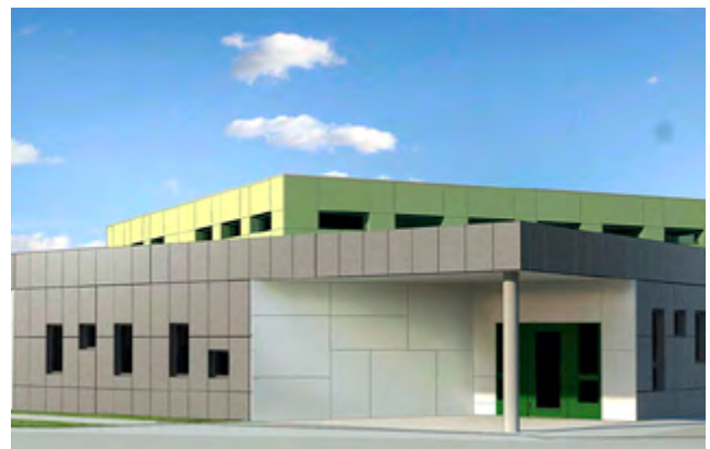
Under 2018 fortsatte projektet med ett nytt gemensamt kontrollrum.
