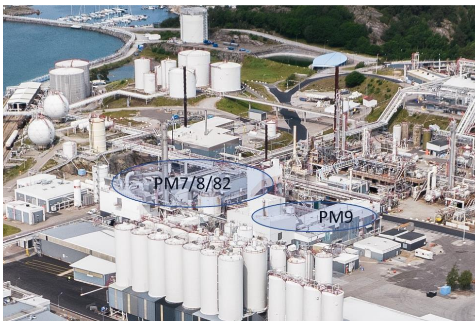
Figur 4. Översiktssbild över PVC-anläggningen.
