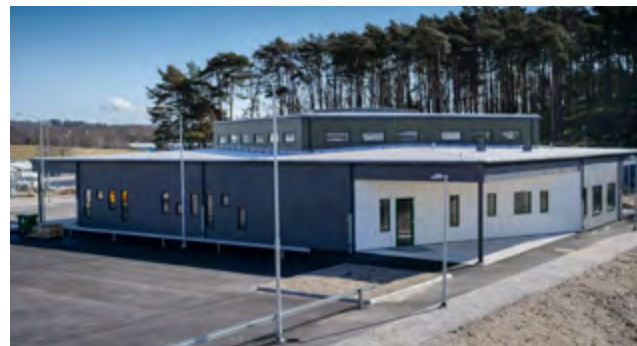
Under 2019 pågick byggnationen av det gemensamma kontrollrummet med första inflyttningen framflyttad till våren 2021.
