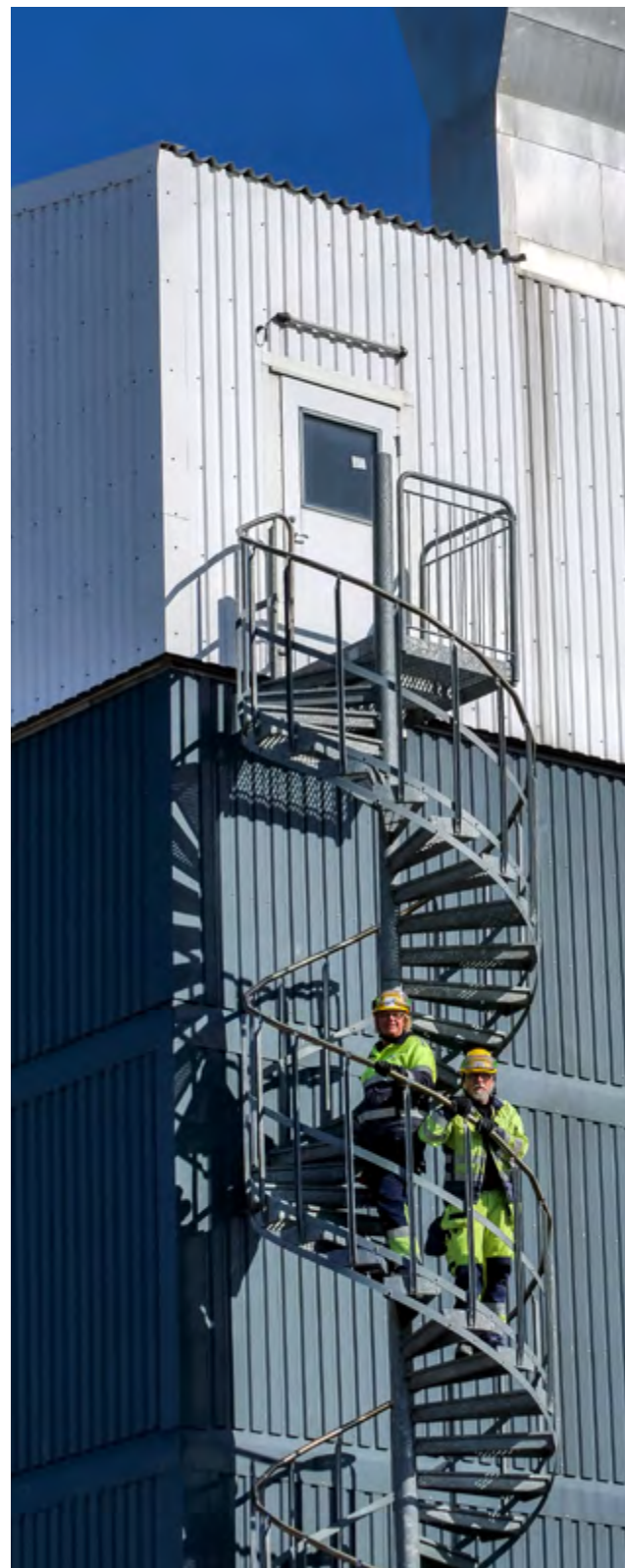
Via en filteranläggning minskas utsläppet av partiklar till luft.
