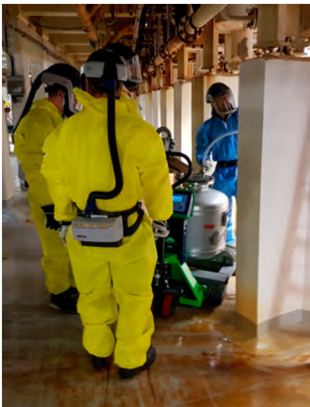
Första tömningen av flytande kvicksilver från en elektrolyscell
